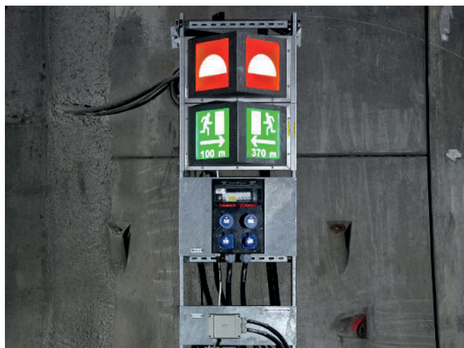
Uscita di sicurezza
